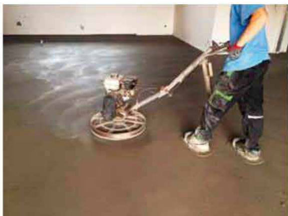
Povrch cementové mazanina se vytváří strojním hlazením. AŘbeton
