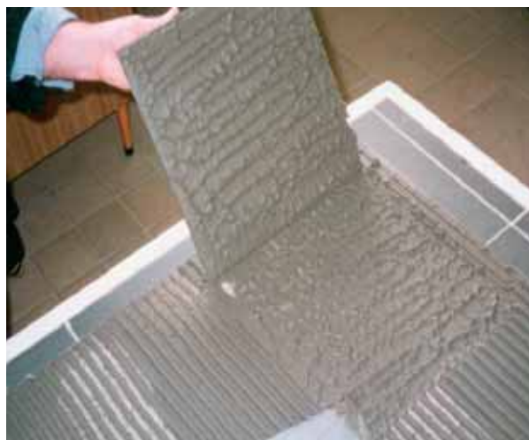
Obr. 5 – Lepení metodou Buttering-Floating
