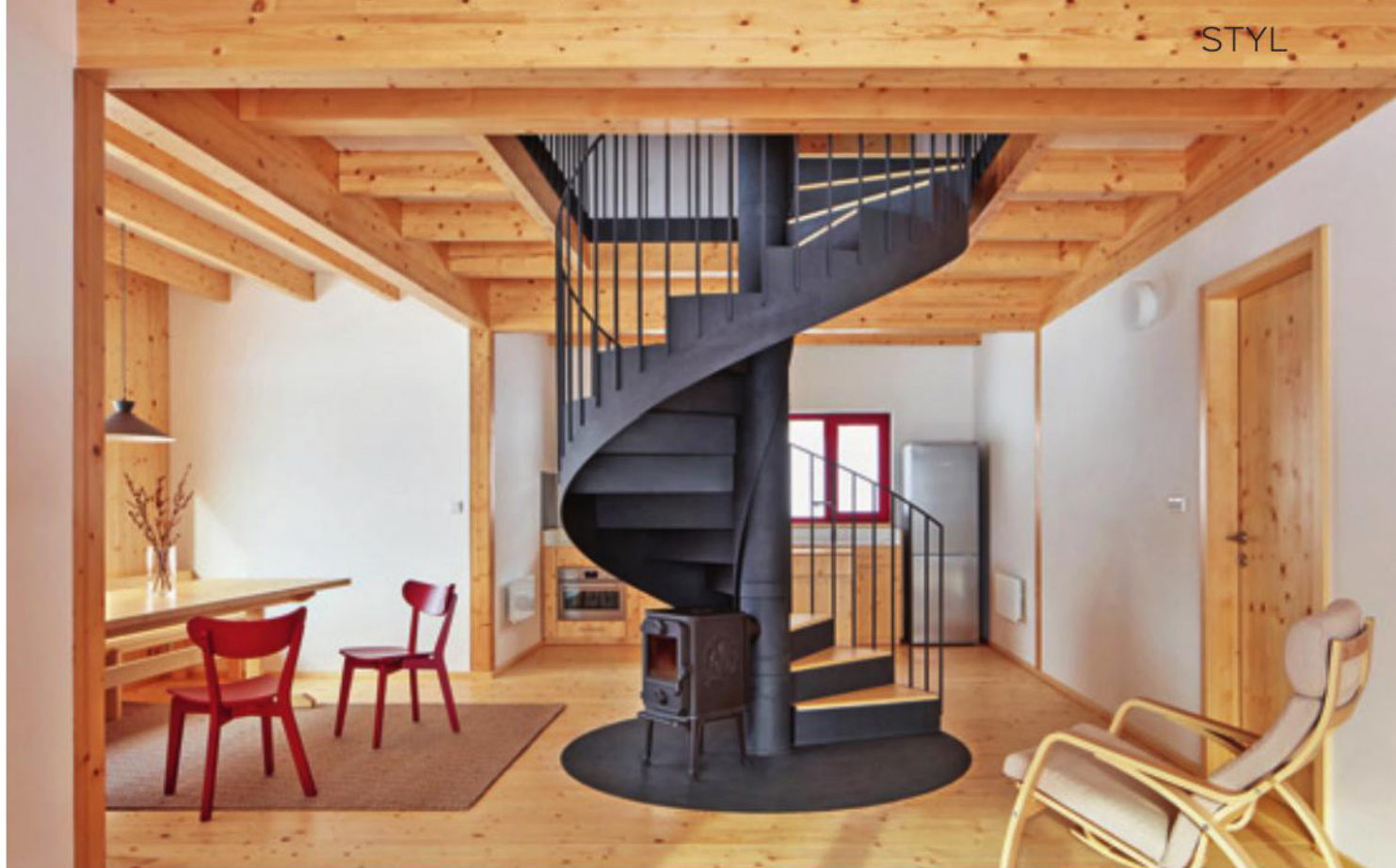
Schodiště od dodavatele Šolc konstrukce se obtáčí okolo komína
