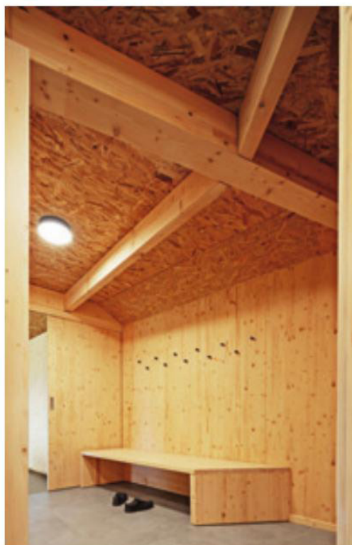
Prostorná vstupní chodba. CLT panely pořídili u Dekwood
