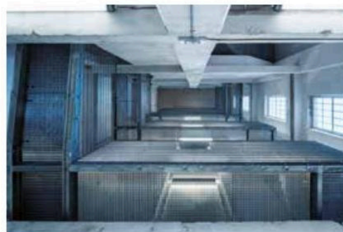
↑ Ocelové schodiště vložené mezi původní železobetonové průvlaky
