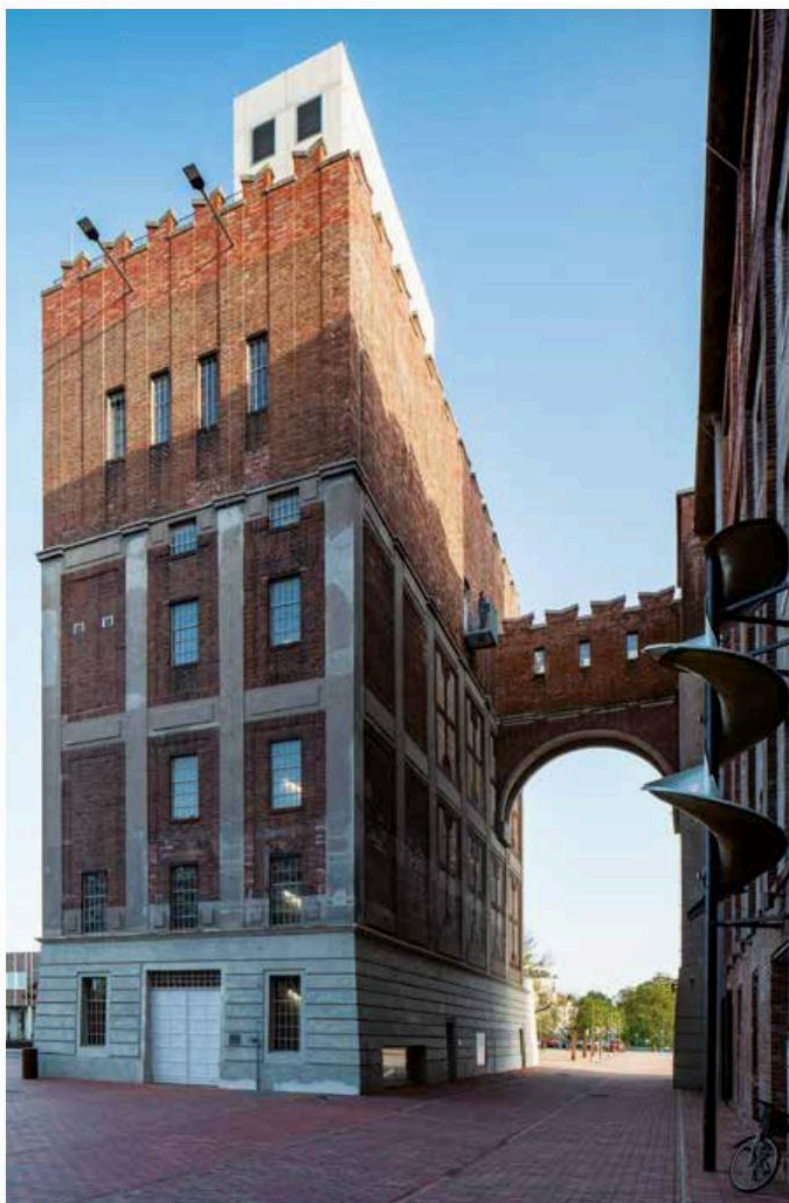
↑ Severní fasáda Sila
