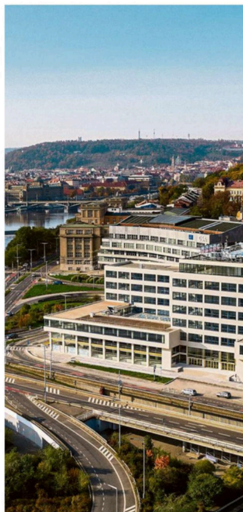
Budova Elektrických podniků stojí v Praze od 30. let
