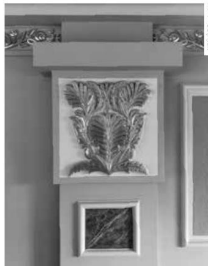
OBNOVENÝ DETAIL ZLACENÍ
