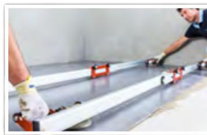
Na přenos obkladového prvku na místo uložení použijte transportní lišty s vakuovými přísavkami. Pracujte ideálně ve dvojici. (foto Mapei)
