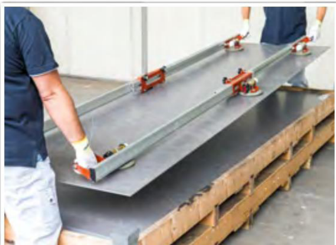
Na manipulaci s obkladem, jeho přenos a instalaci se použijí transportní lišty s nastavitelnými vakuovými přísavkami. Tím se limituje kroucení a ohýbání obkladu. Tlak v manometru přísavky je třeba průběžně kontrolovat. (foto Mapei)
