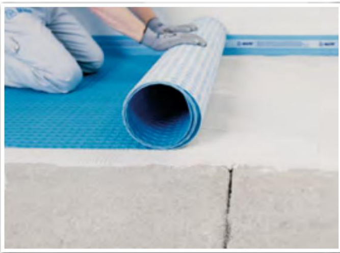
Oddělovací a hydroizolační membrána z hřebínkové HDPE-vrstvy s drsným povrchem a polypropylenovou tkaninou ze spodní strany Mapeguard UM 35 umožňuje kladení dlažby na kritické podklady bez potřeby kopírovat kontrolní a bez dilatační spáry v podkladu. (foto Mapei)
