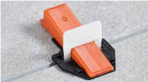
Obr. 24 Podložky pod vyrovnávací klínky
