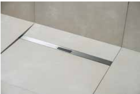
Obr. 22 Použití formátu 80 × 80 cm s vyspádovanou podlahou
