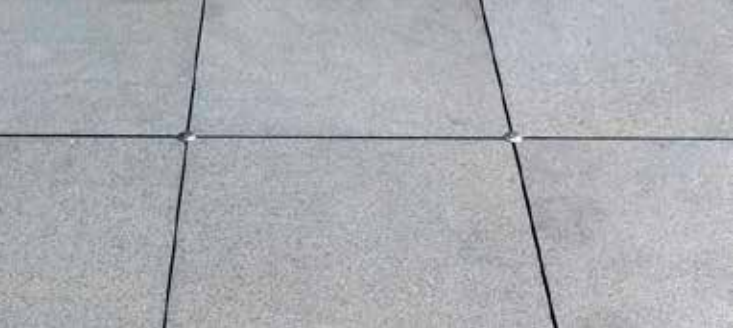
3/ Disky fixující dlaždice proti odtržení
