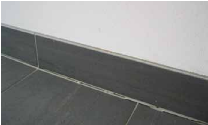
Obr. 29 Pružná dilatační lišta
