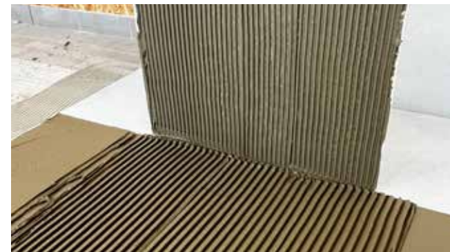
Obr. 15 Lepení metodou buttering-floating
