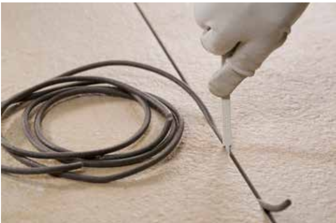
Obr. 28 Řez konstrukční dilatační spárou a profil tmelu se separačním provazcem
