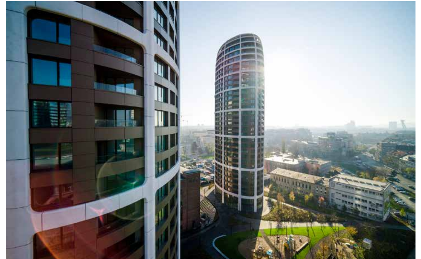
bytový dům Sky Park by Zaha Hadid, SK
