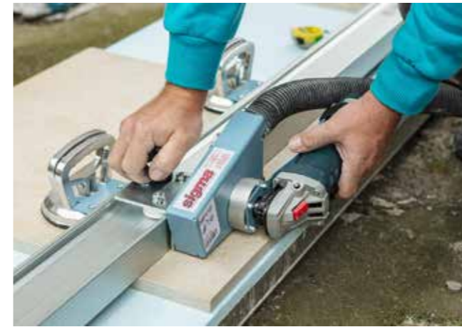
9 | Schneiden der Bodenfliesen mit der Stärke 2 cm Reliefbodenfliesen mit einer Stärke von 2 cm können nur mit elektrischen Schneidemaschinen mit Führungsschiene oder wassergekühlten Sägen geschnitten werden.
