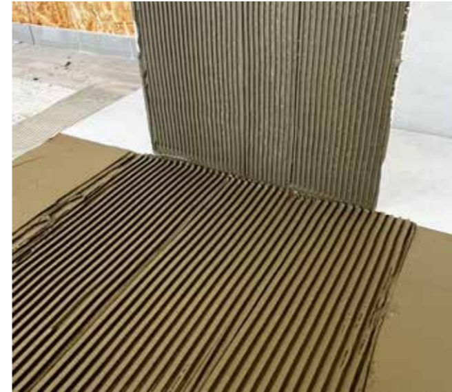
Bild 14 Kleben im Buttering-floating verfahren
