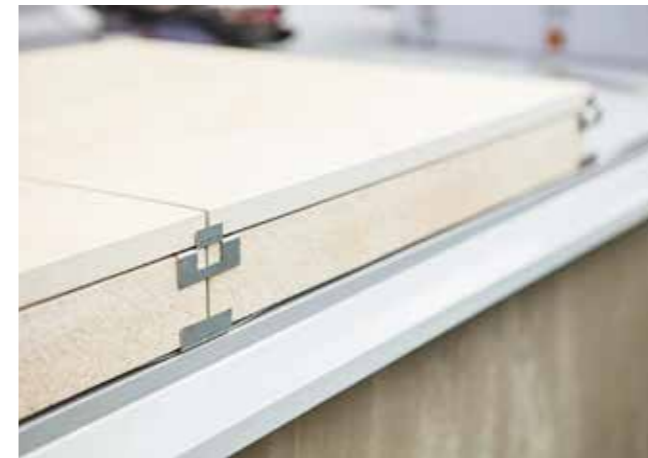
11 | Frontabschluss durch die Tropfkante Die Fliesenstreifen schließen bündig mit dem Abschlussprofil oder der Tropfkante ab.
