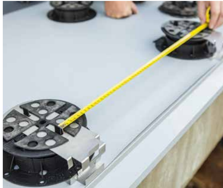
7 | Anbringen der Stelzlager Bevor die Stelzlager befestigt werden, ist der genaue Abstand zu kontrollieren. Bei öffentlich zugänglichen Gebäuden ist eine Mittelpunktstelze einzubauen.
