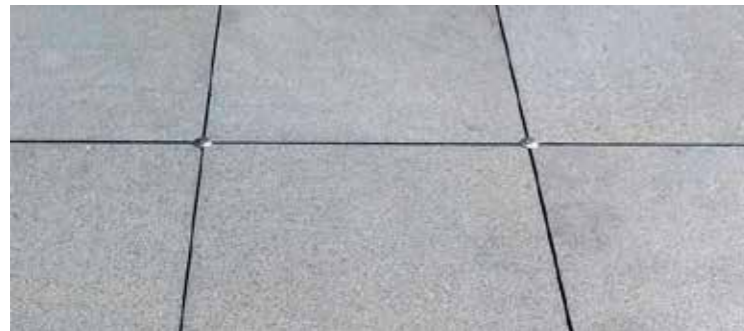
Fliesen-Befestigungsplatten gegen Ablösen
