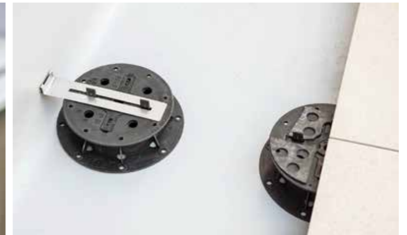
12 | Anbringen der Anschläge zwischen Wand- und Bodenfliese Die zurechtgeschnittenen Fliesen an der Wand werden in vorher anzubringende Anschläge eingelegt. Kunststoffeinsätze am Metallanschlag schützen eine eventuell vorhandene Abdichtung vor Beschädigungen.
