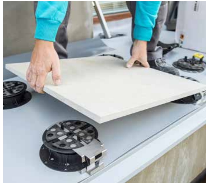
8 | Verlegung der Bodenfliesen Die Bodenfliesen werden in die Stelzlager eingelegt. Nach dem Einlegen ist der richtige Sitz der Platten zu kontrollieren.
