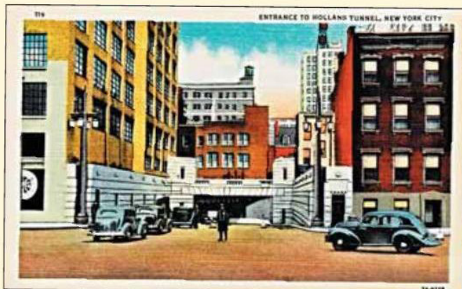
Obr. 9 Vjezd do Hollandova tunelu v New Yorku pro dopravu do New Jersey. Tunel se skládá ze dvou tubusů, každý se dvěma jízdními pruhy. První tubus z New Yorku do New Jersey a druhý z New Jersey do New Yorku. Část tunelu pod řekou Hudson je dlouhá 5480 stop. Frank E. Cooper, 258 Broadway, New York, N. Y. Přelom 30. a 40. let XX. stol. [sbírka autorů].
