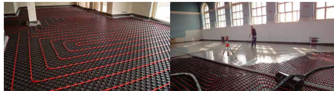
Obr. 16 – Příklad provedení podlahového vytápění – mokrý způsob
