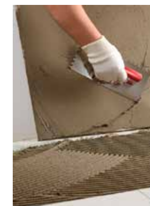
Obr. 13 – Lepení metodou buttering-floating
