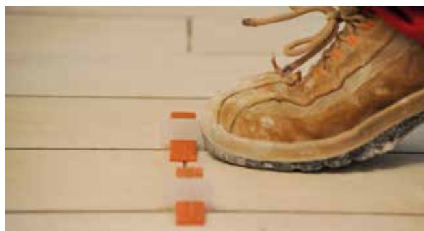
Obr. 9 – Odstranění klínků
