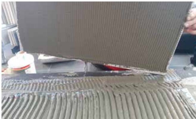
Bild 10 Kleben im Buttering-floating verfahren
