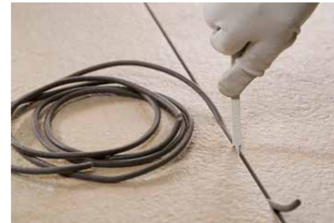
Bild 26 Gerissene Dehnungsfuge ohne Verwendung des Trennseils
