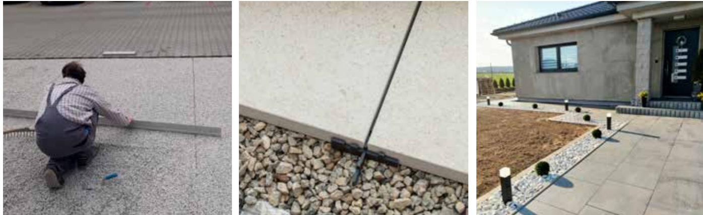
Bild 28, 29 und 30 Verlegung auf Kies
