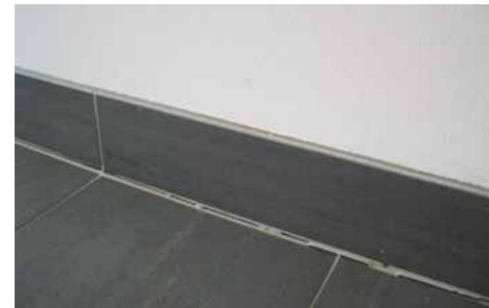
Bild 26 Gerissene Dehnungsfuge ohne Verwendung des Trennseils
