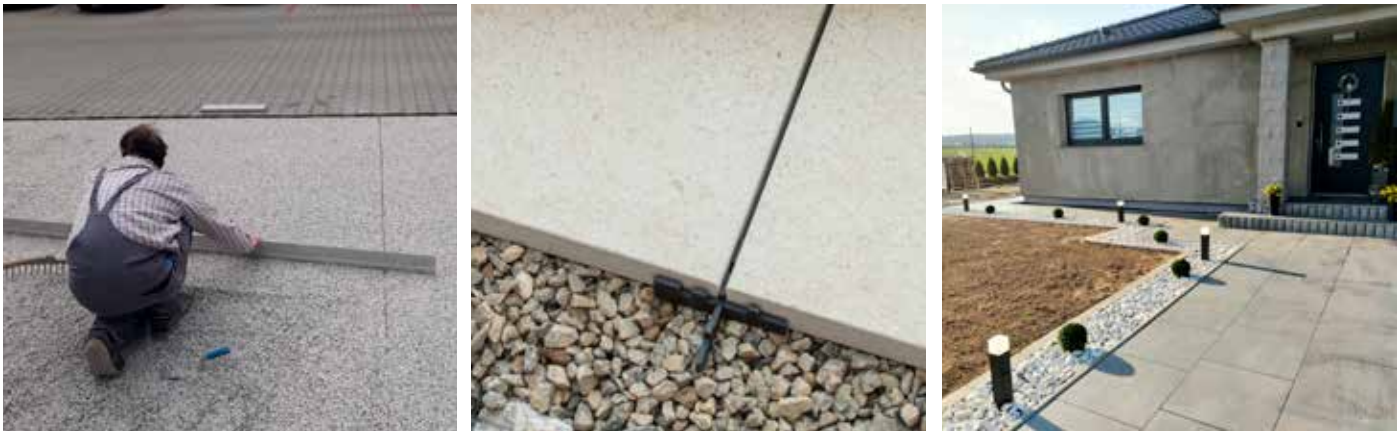
Bild 28, 29 und 30 Verlegung auf Kies
