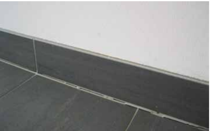
Bild 26 Gerissene Dehnungsfuge ohne Verwendung des Trennseils
