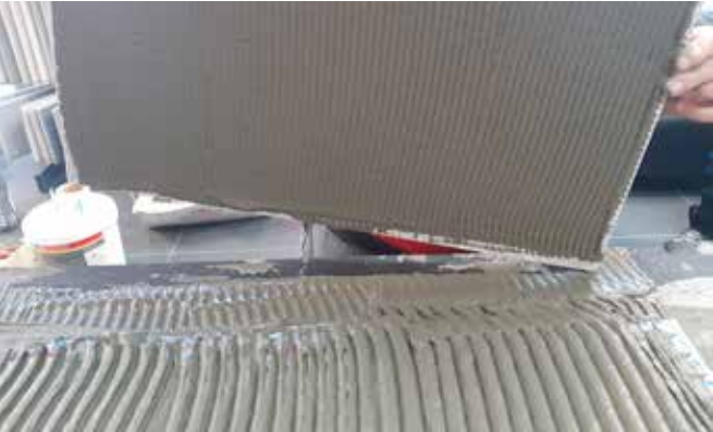
Bild 10 Kleben im Buttering-floating verfahren
