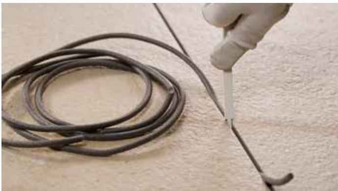
Bild 26 Gerissene Dehnungsfuge ohne Verwendung des Trennseils
