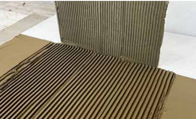
Bild 10 Kleben im Buttering-floating verfahren
