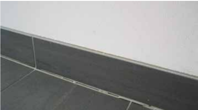
Bild 26 Gerissene Dehnungsfuge ohne Verwendung des Trennseils
